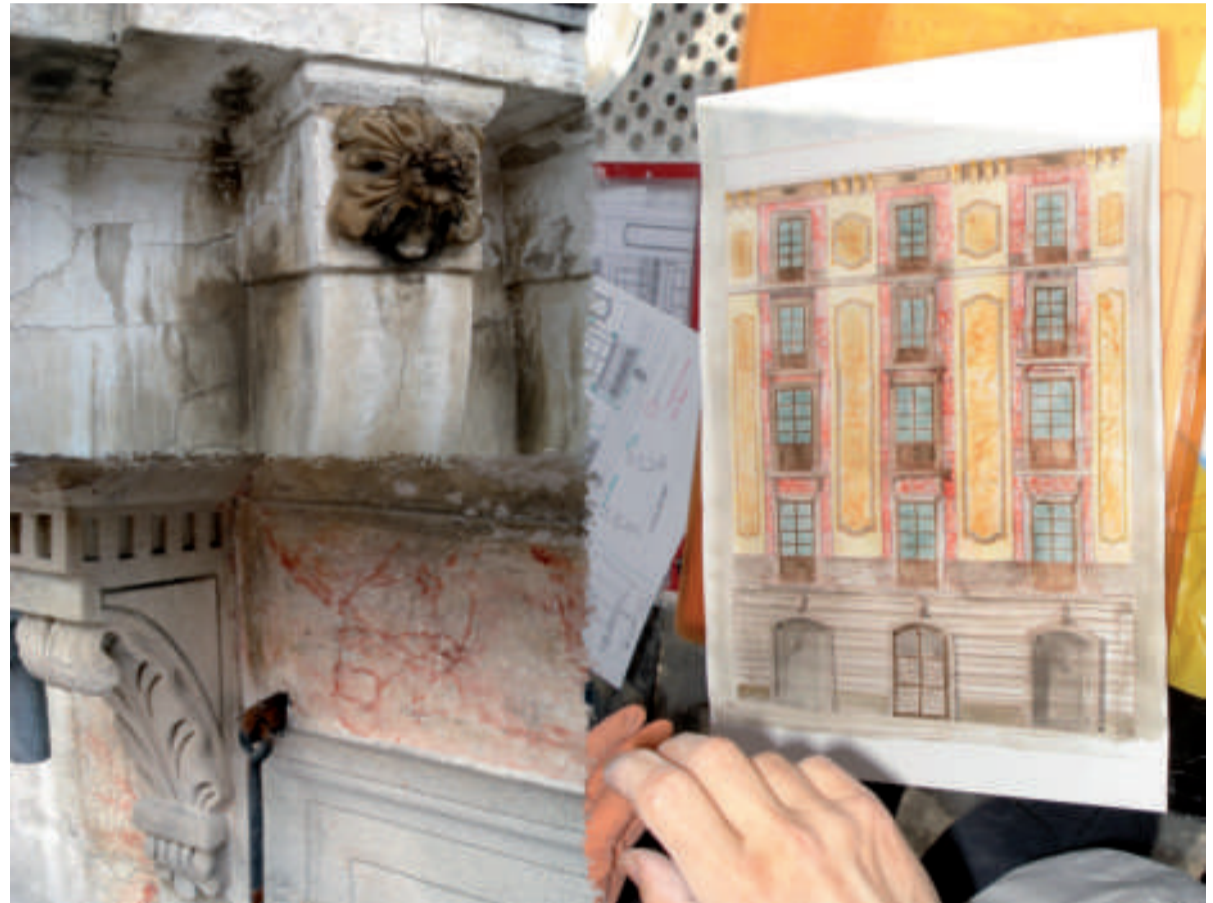
OBRA TRAC. C/CARME, 30. FAÇANA DEL SEGLE XIX EN PROCÉS DE REHABILITACIÓ. DETALL DE L'ESCULTURA DE TERRACOTA, DEL MARBREJAT, I DEL DIBUIX DE LA RESTAURADORA QUE HA ESTAT INDISPENSABLE PER COMPRENDRE LA COMPOSICIÓ ORNAMENTAL I CROMÀTICA ORIGINAL DE LA FAÇANA.
