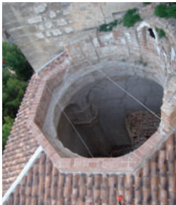
(IMATGE ESQUERRA I SUPERIOR) PROCÉS DE REHABILITACIÓ DE LA CÚPULA NORD-EST
