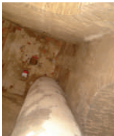
GRAPAT DE L'ESCALA DE CARGOL D'ACCÉS AL CAMPANAR AMB FIBRES DE CARBONI I ACABAT AMB ESTUC DE CALÇ
