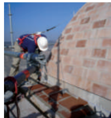
CONSOLIDACIÓ D'ESTRUCTURA DE COBERTA DEL CAMPANAR AMB CALÇ, SUBSTITUCIÓ DE TOTXOS I ACABAT CERÀMIC AMB SELECCIÓ DE PECES LLIGADES AMB MORTER DE CALÇ
